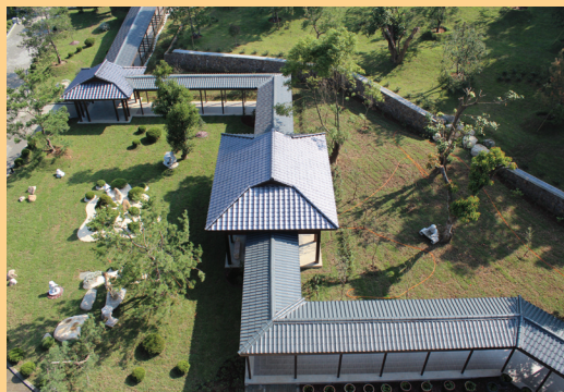
設計優美的蜿蜒廊道連接關房與新建大樓。（妙雲蘭若提供）
