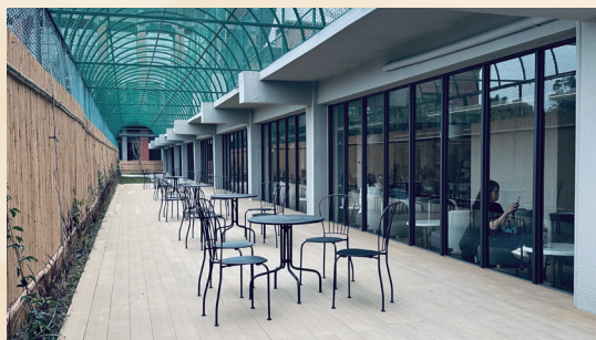
▲ 戶外設置木質平台，以拱形植栽架構引入藤蔓植物，並以竹牆作為鐵絲網的外層肌理，以柔化邊界，形成遮蔭效果與景觀層次，弱化原有生硬界面。（達觀設計公司提供）
