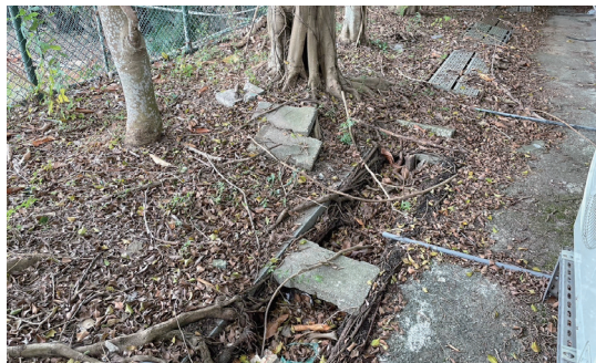
▲ 戶外北側榕樹根系盤錯，不僅破壞排水系統，亦導致豪雨時積水回流室內。（達觀設計公司提供）
