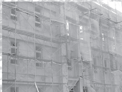
目前已完成鋁門窗之安裝工程。（96.8.13）
